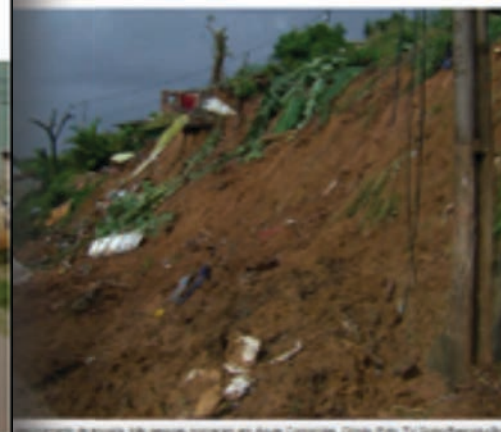
Após chuva forte, 80 pessoas ficaram sem moradia em Olinda. Segundo a prefeitura, a maioria delas vive no bairro de Águas Compridas, onde duas mulheres e uma criança de 8 anos morreram soterradas após um deslizamento de terra.
