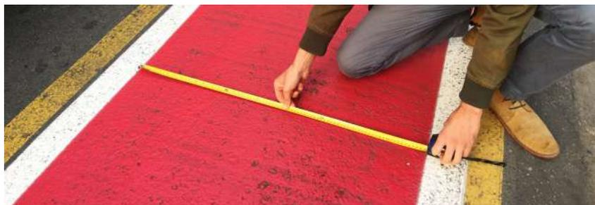
**Figura 27.** Ciclovía unidireccional muy estrecha. 90cm de ancho
