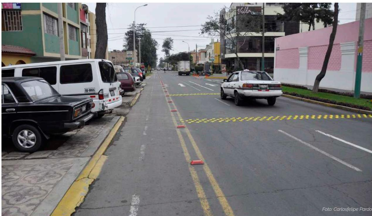
**Figura 25.** Ciclocarril bidireccional en frente de estacionamiento perpendicular
