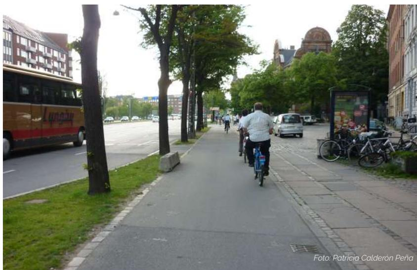
**Figura 34.** Ciclovía unidireccional elevada (2,10 m) con separador duro (1,00 m) en Copenhague, Dinamarca.
