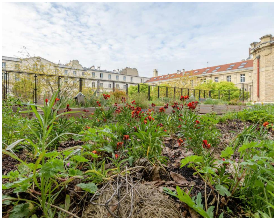
Roof of the school « Rue de Boursault »
