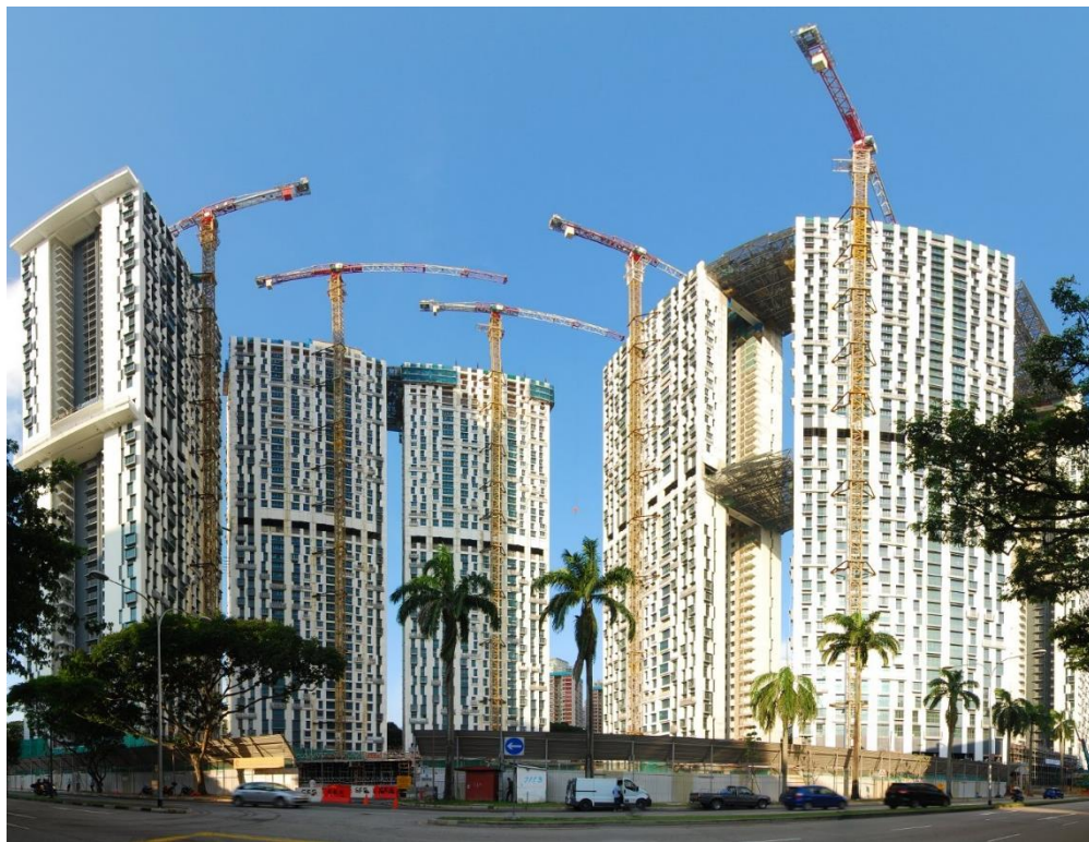
新加坡正在建设的公共住房
