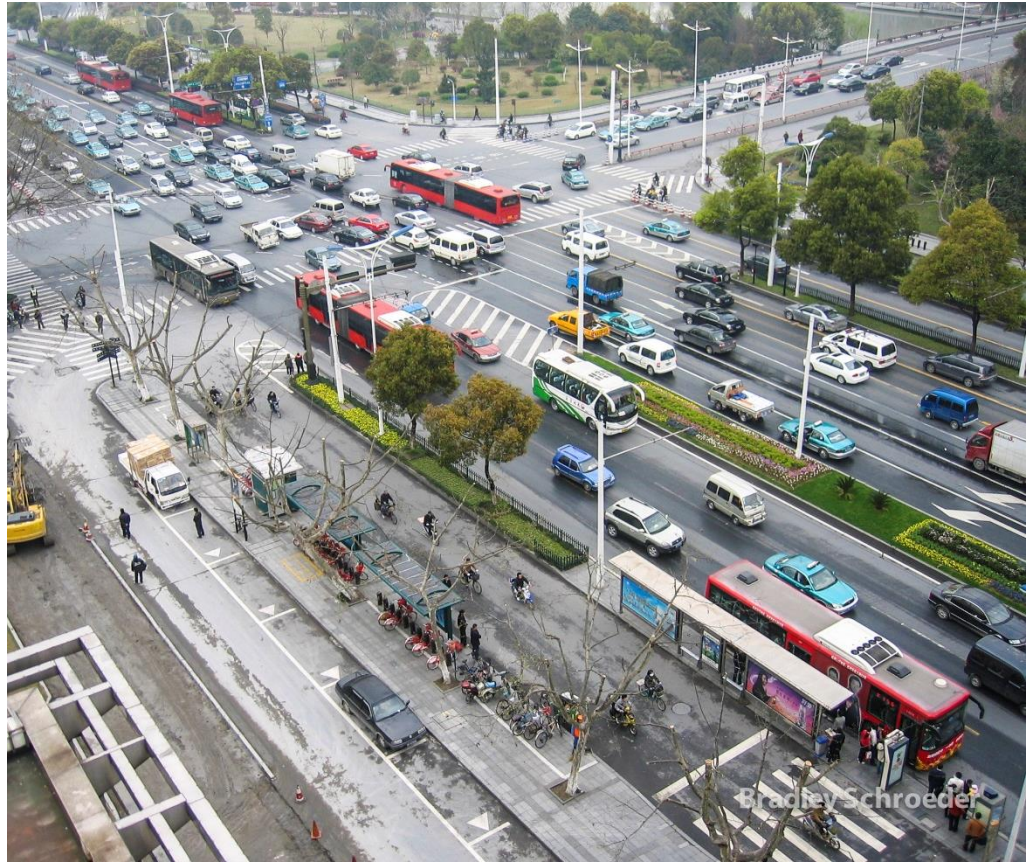
中国杭州市某一站点区域
